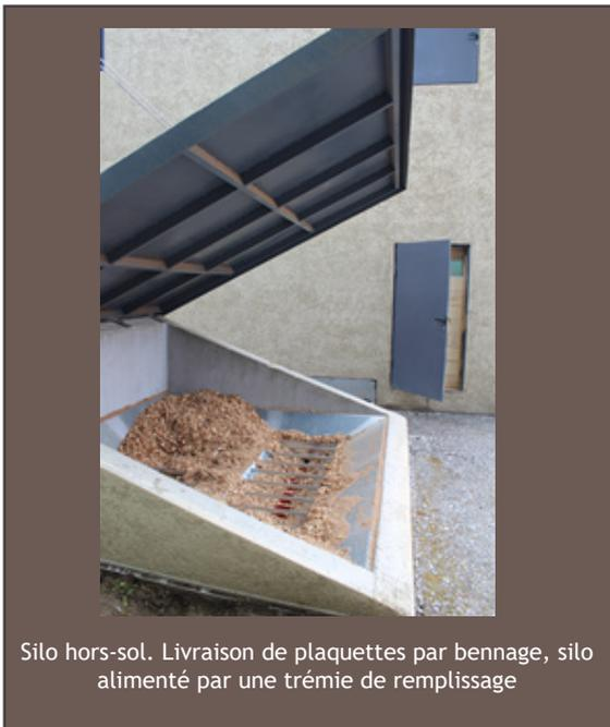
Silo hors-sol. Livraison de plaquettes par bennage, silo alimenté par une trémie de remplissage
