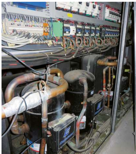
Figure 25 : Vue interne PAC sur eau de mer (Centre aquatique - Plougonvelin)
