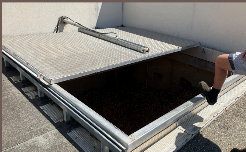
Exterieur de la chaufferie - silo
