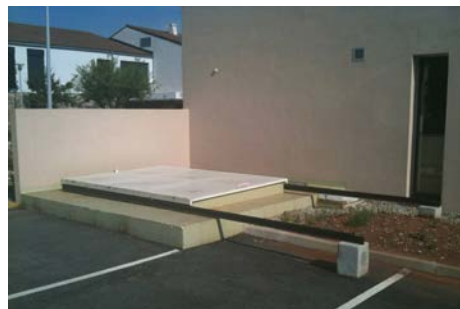
Trappe coulissante Chaufferie au Luc en Provence (83) - 150 kW
