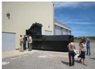
Chaufferie de Manosque 4,5 MW (04)
