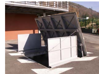
Trappe carrossable ouverte Collège St Vallier de Thiey (06) - 560 kW
