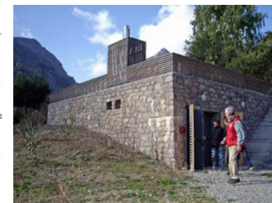
Chaufferie communale de Champoléon 180 kW bois (05) Exemple d'intégration architecturale
