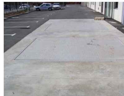
Trappe carrossable fermée Lycée du Muy (83) - 960 kW
