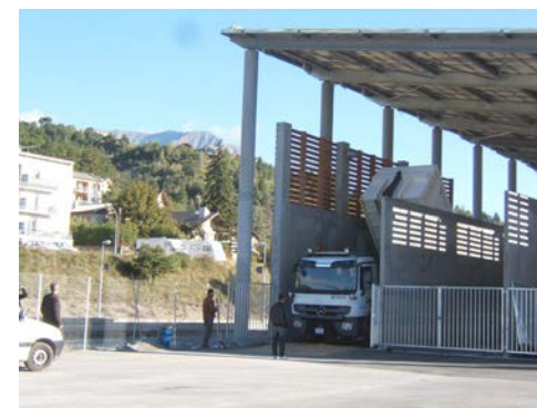
Chaufferie du réseau de la gare d'Embrun 1500 kW bois (05)
